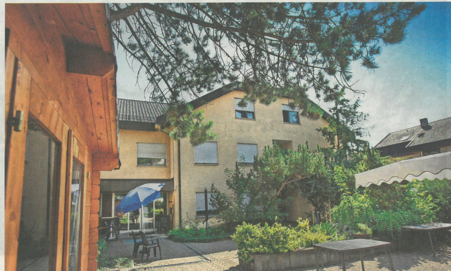
Das Wohnheim in Heiningen muss die Lebenshilfe aufgeben.
