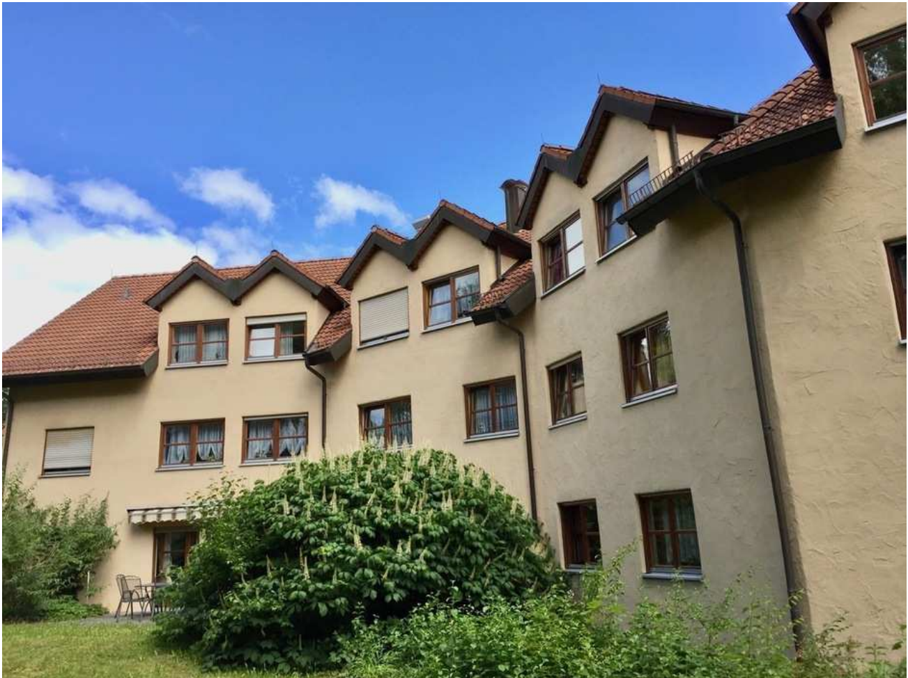
Das Wohnheim am Daimlerplatz in Geislingen: Wegen der neuen Landesheimbauverordnung und wegen schärferer Brandschutzauflagen muss die Lebenshilfe das Haus aufgeben. © Foto: Roderich Schmauz
