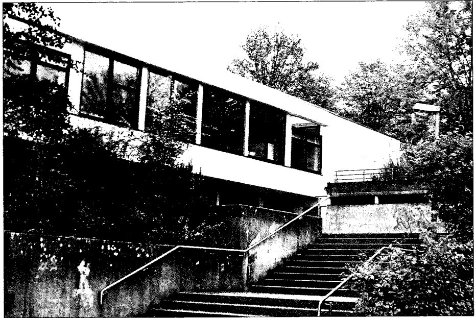
Die ehemalige Waldeckschule wird saniert und der Lebenshilfe langfristig als Bildungseinrichtung dienen.
